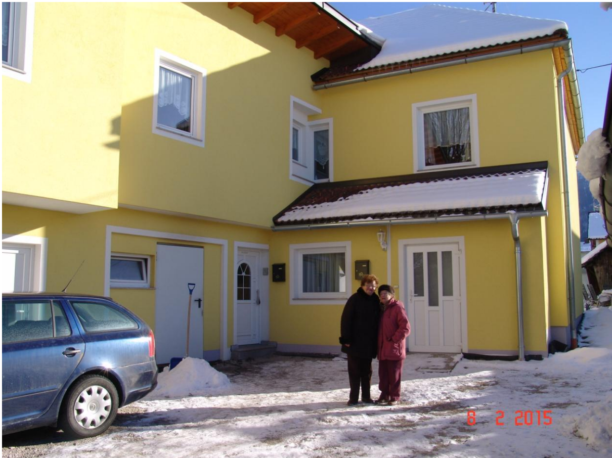
Shenja mit Inge vor dem Anbau. Links das Wohnhaus von Ramona und Andreas mit ihren drei Kindern.
